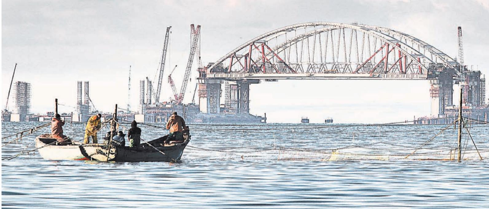
Арки - самые большие элементы конструкции моста, были изготовлены на крупнейшем предприятии России в области мостостроения - заводе «Воронежстальмост». Автомобильная арка, которую на днях установили над фарватером, весит 5,5 тыс. тонн. Свободное пространство под ней шириной 185 метров и высотой 35 метров обеспечит проход всех типов судов. Движение автомобилей по мосту планируют начать в декабре 2018 г., а поезда пойдут через год.
