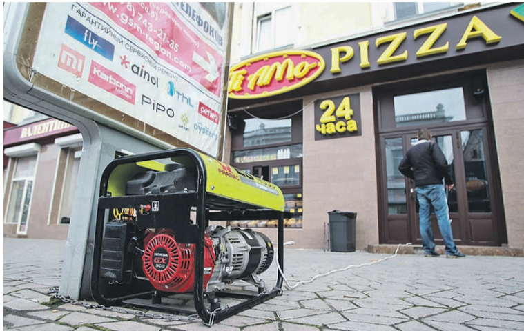
← Маленькие магазины продолжают работать. Небольшого дизель-генератора (вверху), вынесенного на улицу, достаточно, чтобы обеспечить работу кассы (внизу) и осветить полки и витрины двумя-тремя лампочками (слева)
