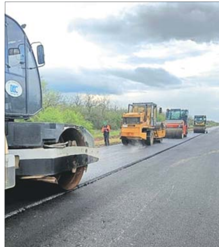
Ремонт трассы Шахты-Цимлянск планируют завершить к концу 2025 года.
