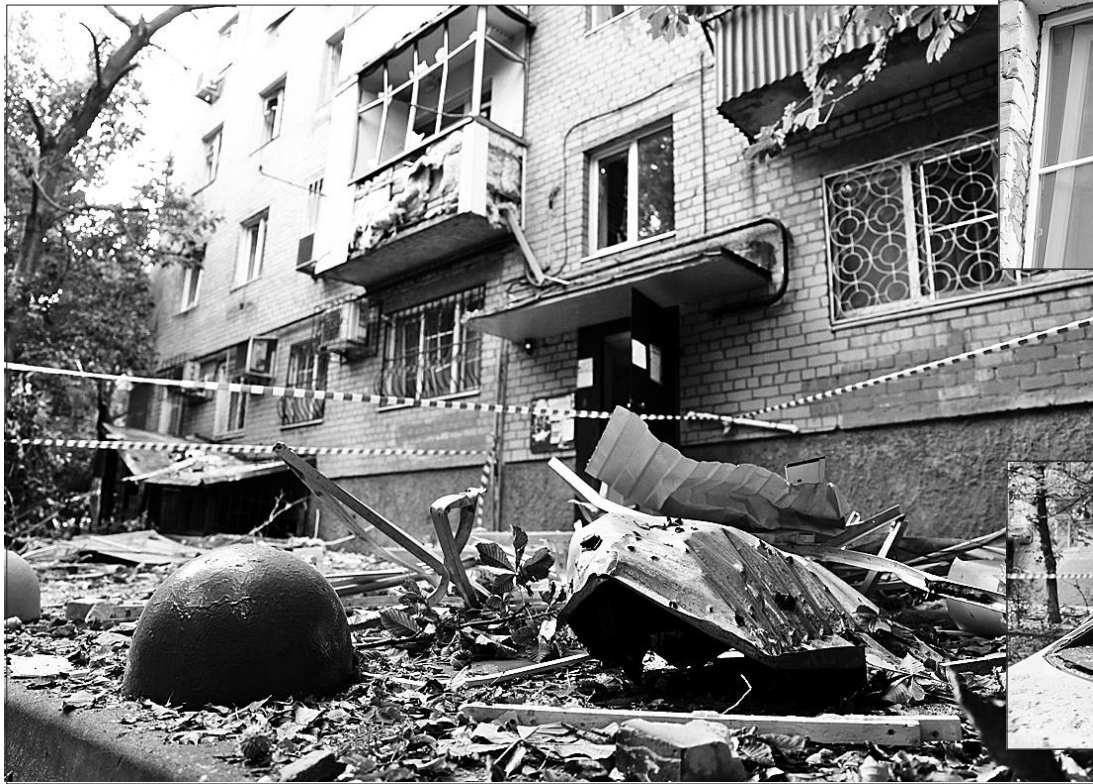
Повреждения зафиксировали в 19 многоэтажках и нескольких зданиях.
