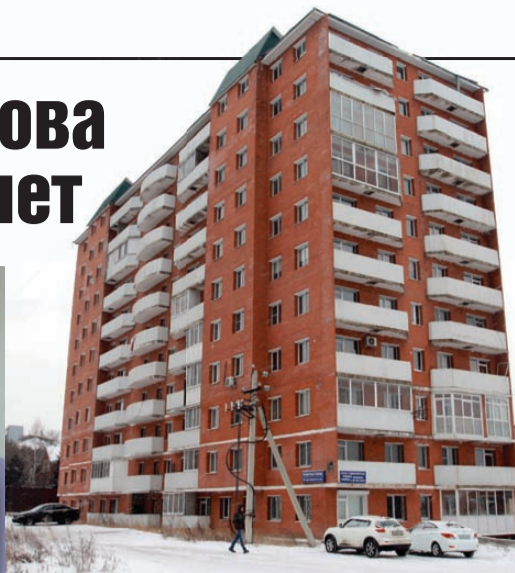
Дом возвели с нарушениями и разрешения на строительство нет.
