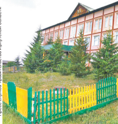
Обновленные здания в селах.
