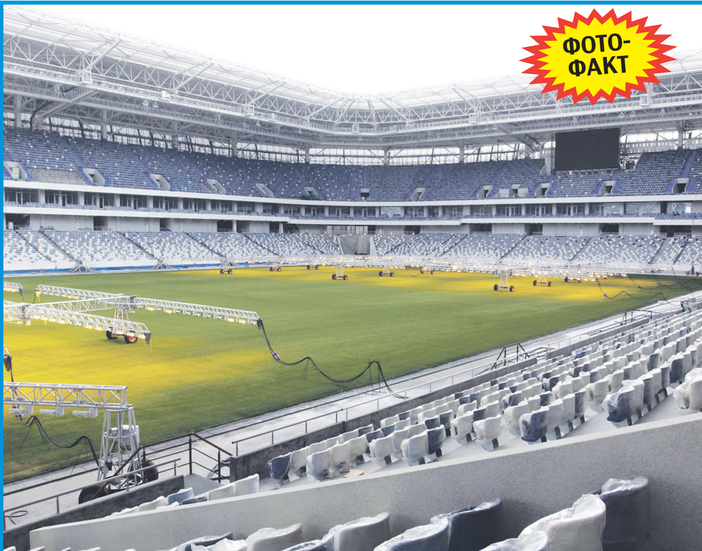
Подрядчик опубликовал очередную подборку снимков из серии «Стадион «Калининград» прямо сейчас». На этот раз фото сделаны внутри арены. Здесь продолжают отделочные работы, а на футбольном поле, как видно, все еще находятся установки дополнительного освещения, которые помогают газону расти.
