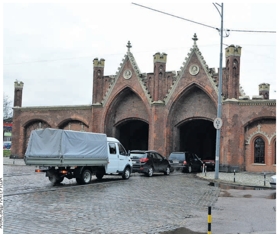
Сейчас движение через ворота открыто в обе стороны.
