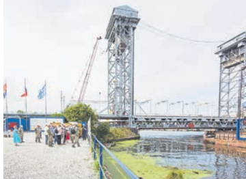
Разводы выявлены около двухъярусного моста.
