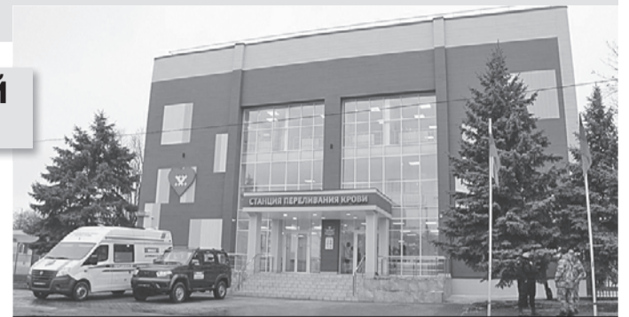
Строительство нового перинатального центра в Донецке.
