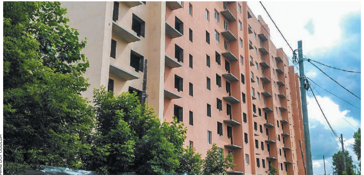
Для завершения строительства дома на улице Гагарина предстоит еще многое сделать, и сейчас ведется составление сметы на оставшиеся работы.
