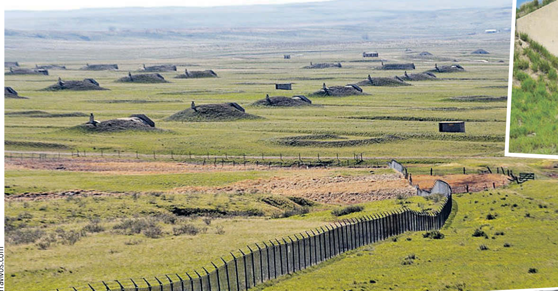
Эта поляна, точнее, сооружения под ней, рассчитана на размещение 5000 человек в случае катастрофического ЧП.
