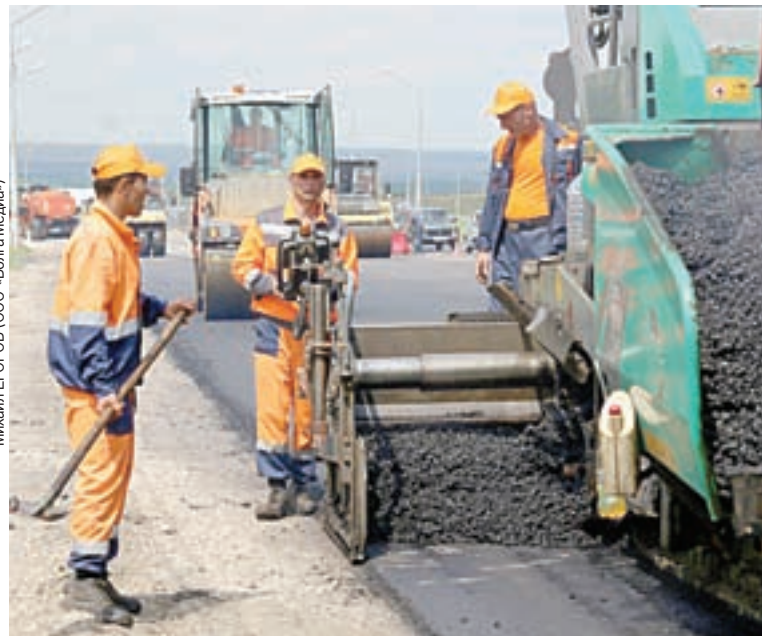
Новые саратовские дороги успешно прошли проверки на качество. Кстати, верхний слой асфальтобетона должен быть не тоньше восьми сантиметров.
