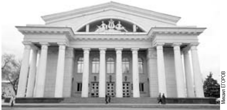
Здание театра оперы и балета нуждается в ремонте. Но его состояние не критично.
