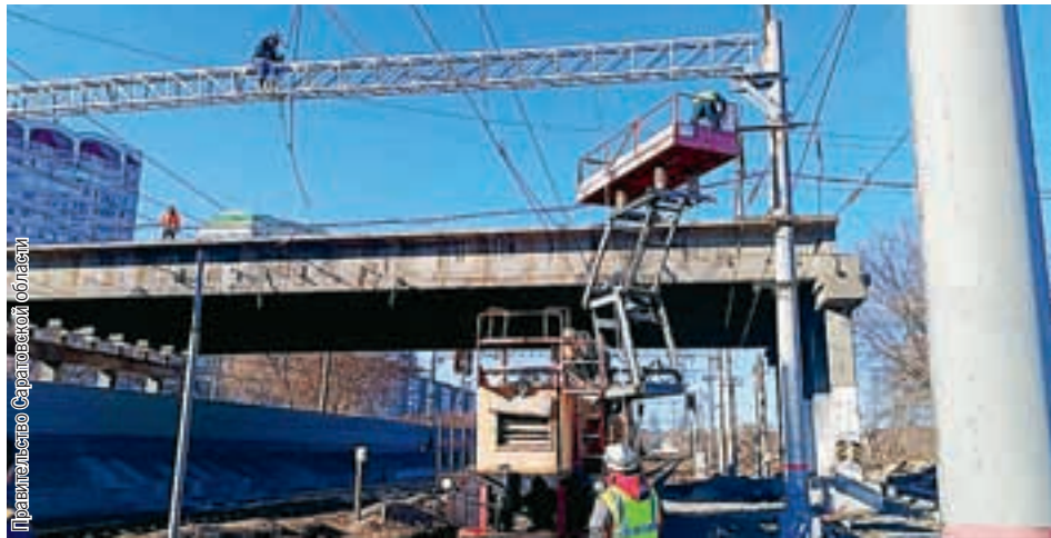
В районе Стрелки рабочие трудятся над демонтажом путепровода.
