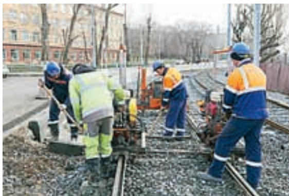
Проверка путей выполнена на 50%.
