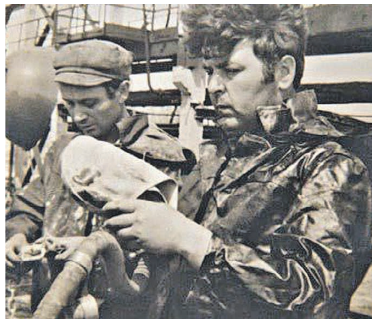
Иосиф Душанек на строительстве ПК «Шесхарис».
