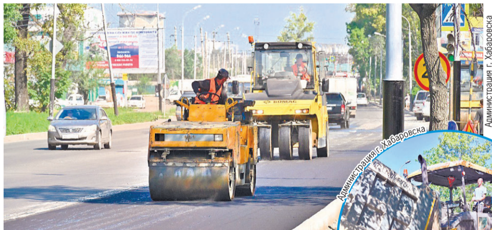
В работе используют износоустойчивое асфальтобетонное покрытие.
