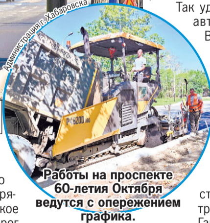
В работе используют износоустойчивое асфальтобетонное покрытие.
