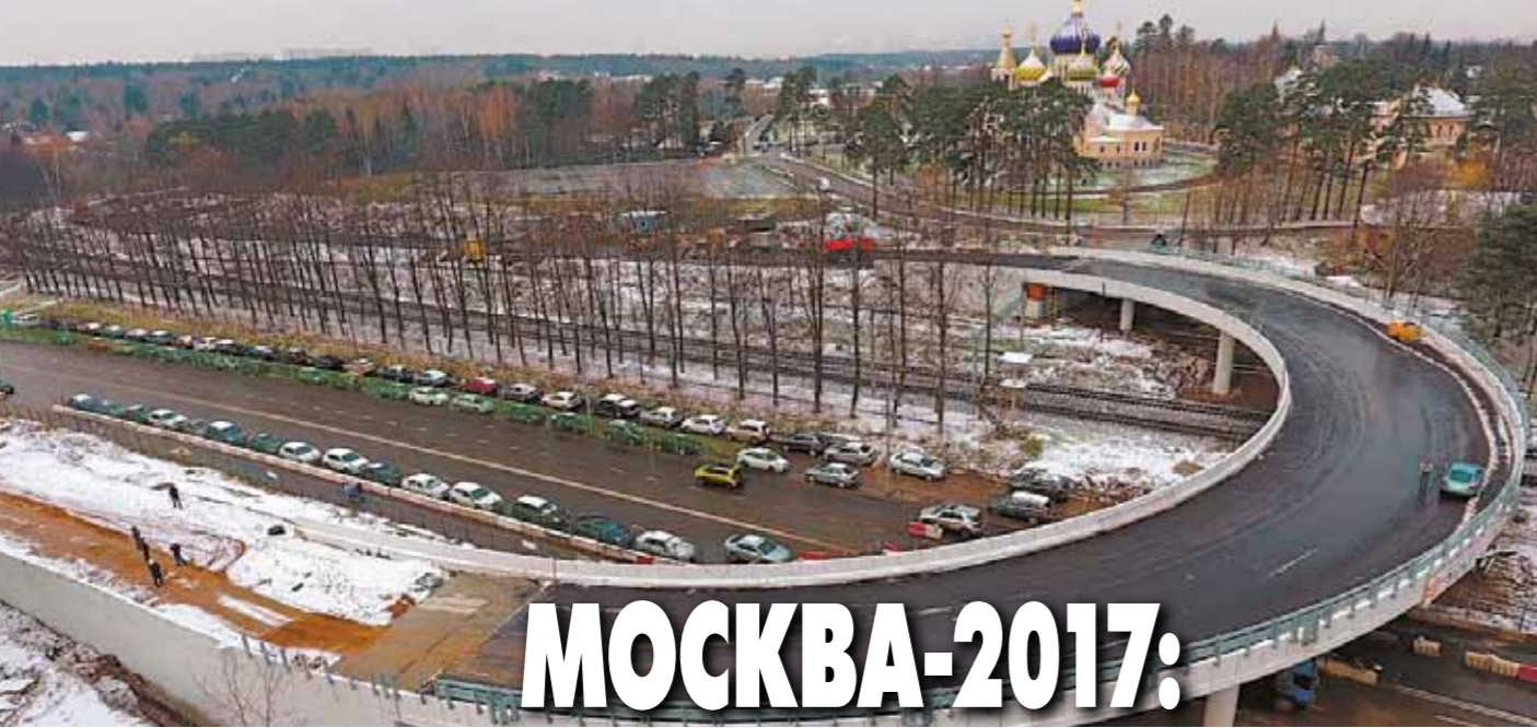
Строится эстакада над проездом в Перелелкино.
