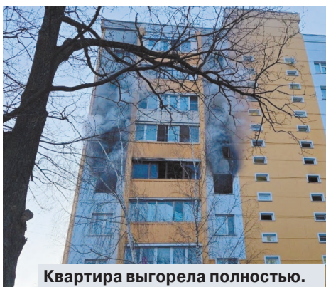
Квартира выгорела полностью.
