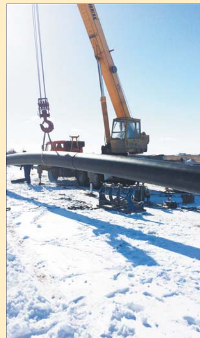
В городе Шахты капитально отремонтировали водовод.
