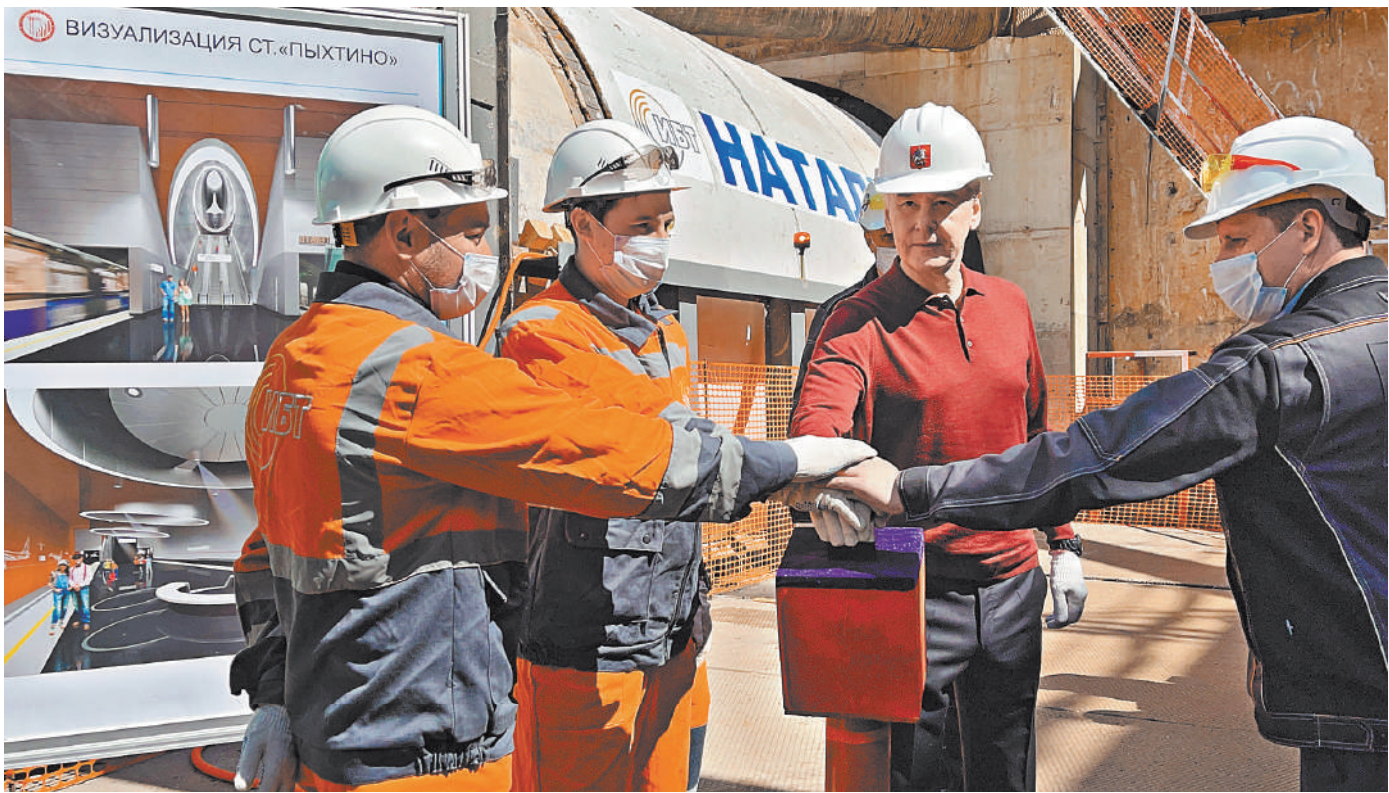
Старт проходке нового тоннеля Сергей Собянин дал вместе с метростроителями.
