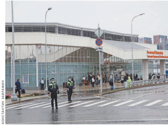
Восточный не похож ни на один московский вокзал — здесь мало архитектуры и много практичности.
