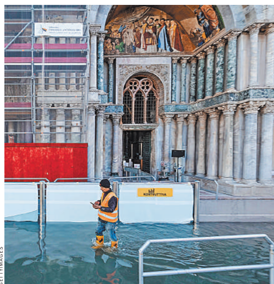
Базилка Святого Марка впервые попробовали защитить от наводнения барьерами. Теперь кругом вода, а в здании сухо.
