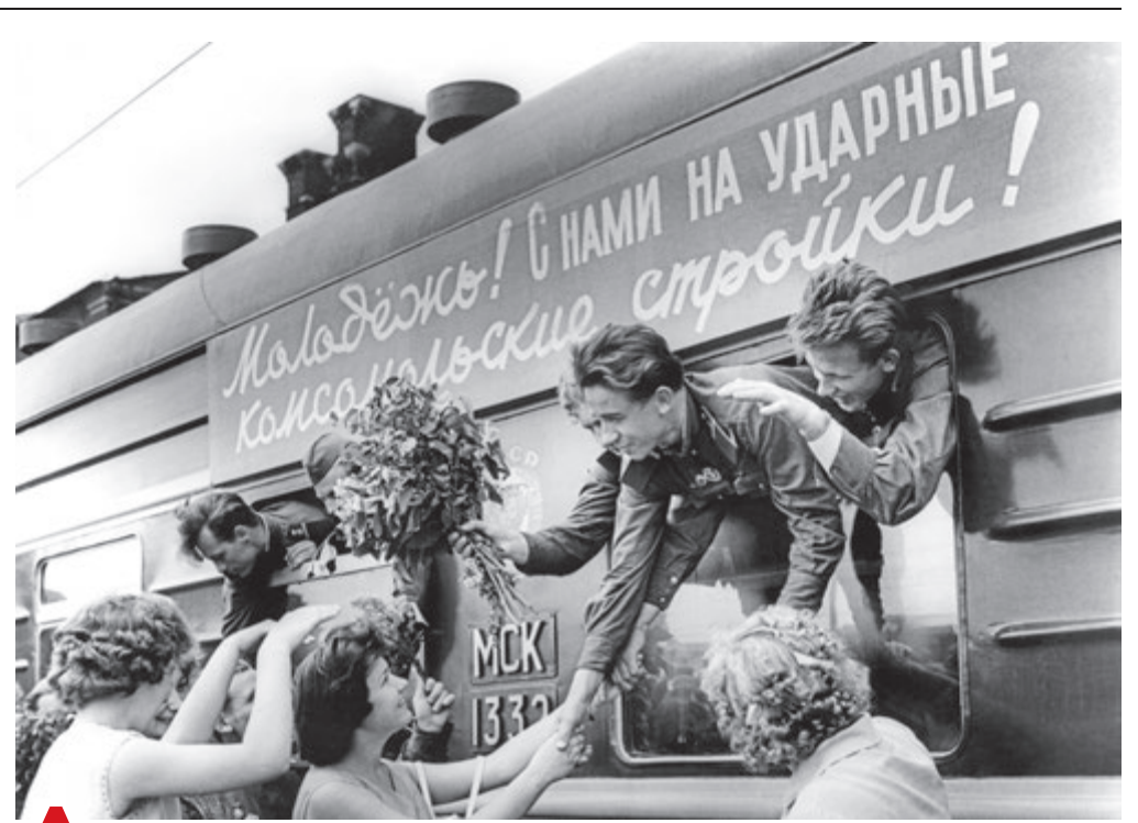
1963 год. Очередной отряд комсомольцев-добровольцев отправляется на ударную стройку — на возведение Братской ГЭС на Ангаре. Посмотрите, какие лица!
