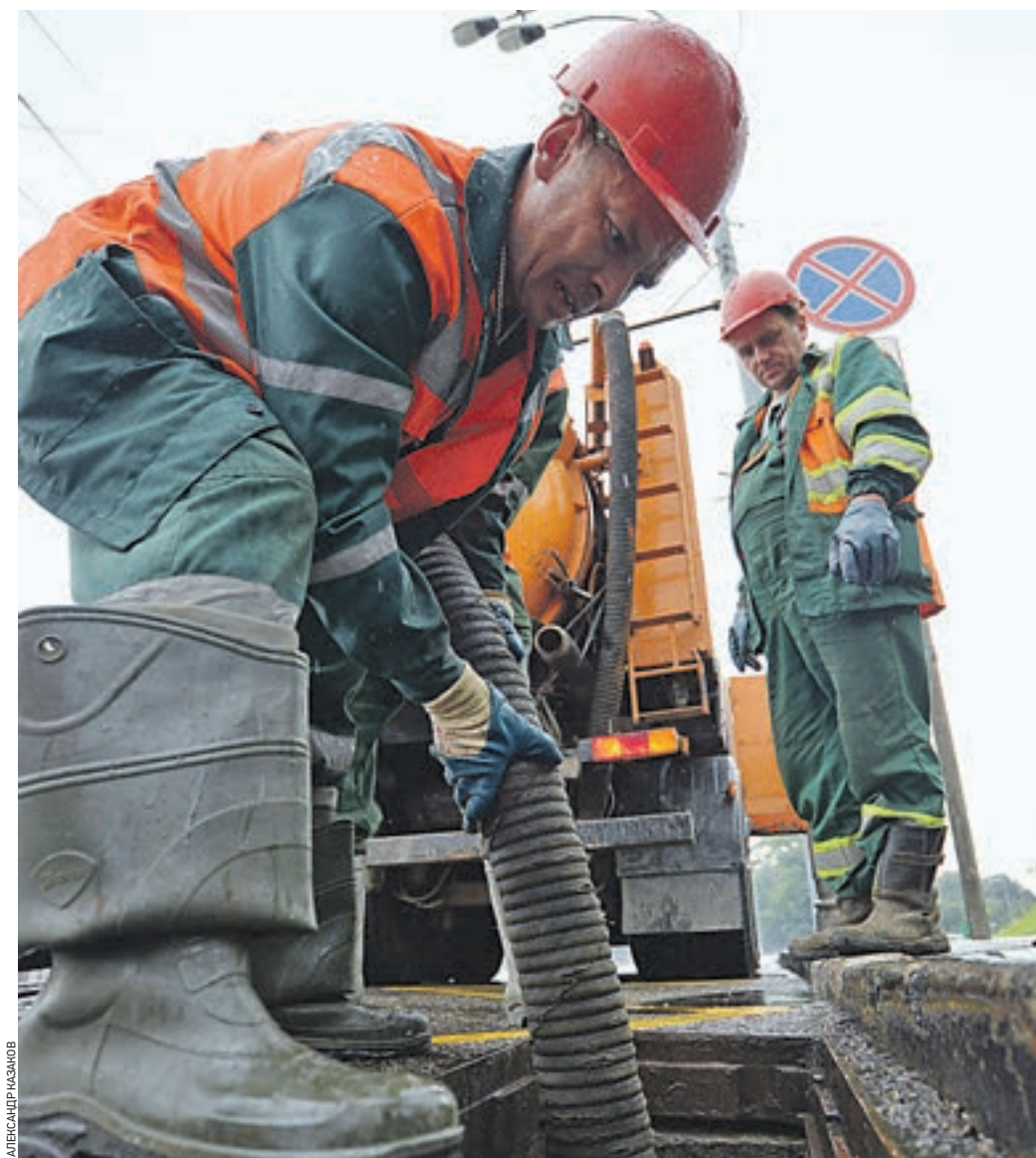
27 июня 13:45 Садовая-Самотечная улица. Рабочие Мосводостока очищают дождеприемную решетку
