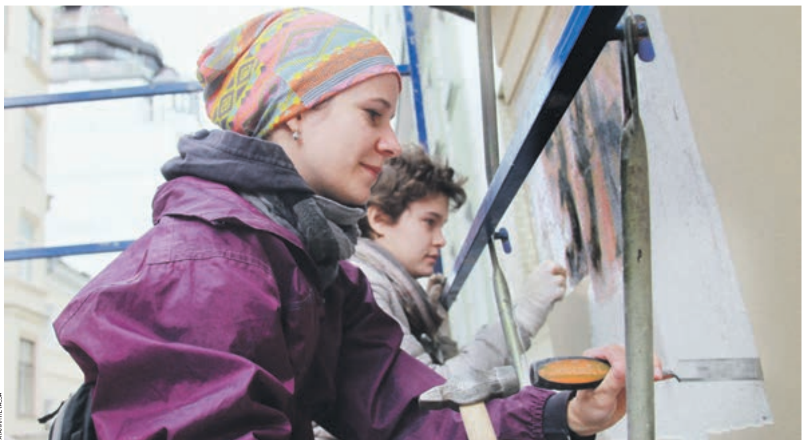
Вчера 12:45 Реставраторы Елена Медведева (на переднем плане) и Мария Вересоцкая снимают слой старой штукатурки на фасаде. Здесь обнаружилась уникальная вывеска, сохранившаяся с 1920 года. Теперь «призрачная надпись» станет новой достопримечательностью столицы
