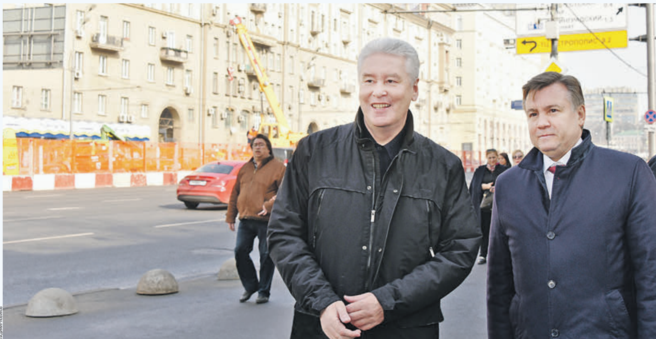
Вчера 11:10 Мэр Москвы Сергей Собянин (на фото слева) осмотрел ход реконструкции водопроводной магистрали на Большой Садовой улице. Гендиректор АО «Мосводоканал» Александр Пономаренко (справа) доложил ему, что в работе используют полиэтиленовые трубы. Это позволяет сократить финансовые затраты и срок выполнения работ
