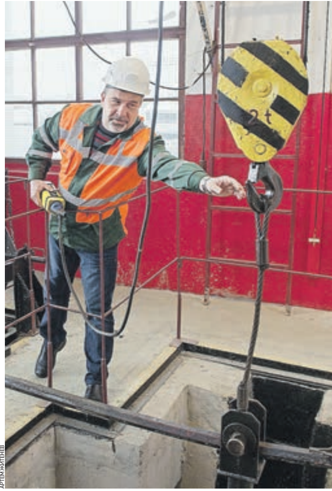
Вчера 10:23 Старший мастер ГУП «Мосводосток» ИГТР № 2 Андрей Калашников с помощью пульта поднимает шандор и регулирует объем подачи воды
