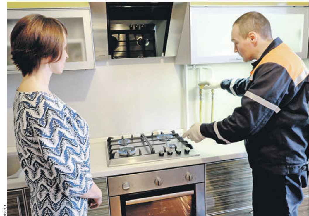
Вчера 11:32 Чтобы заменить систему газоснабжения в доме, сотрудники Мосгаза должны получить доступ во все квартиры
