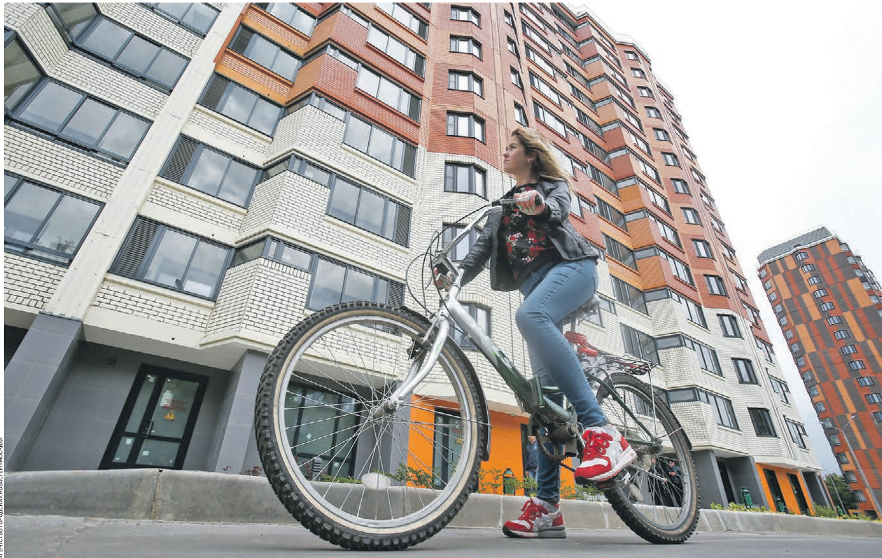
3 ноября 2018 года. Дом, построенный по программе реновации на северо-востоке Москвы. В новых домах практически всегда предусмотрены отдельные комнаты для хранения вещей, зимние сады, террасы и другие удобства. Важно уметь выбрать подходящие именно вам
