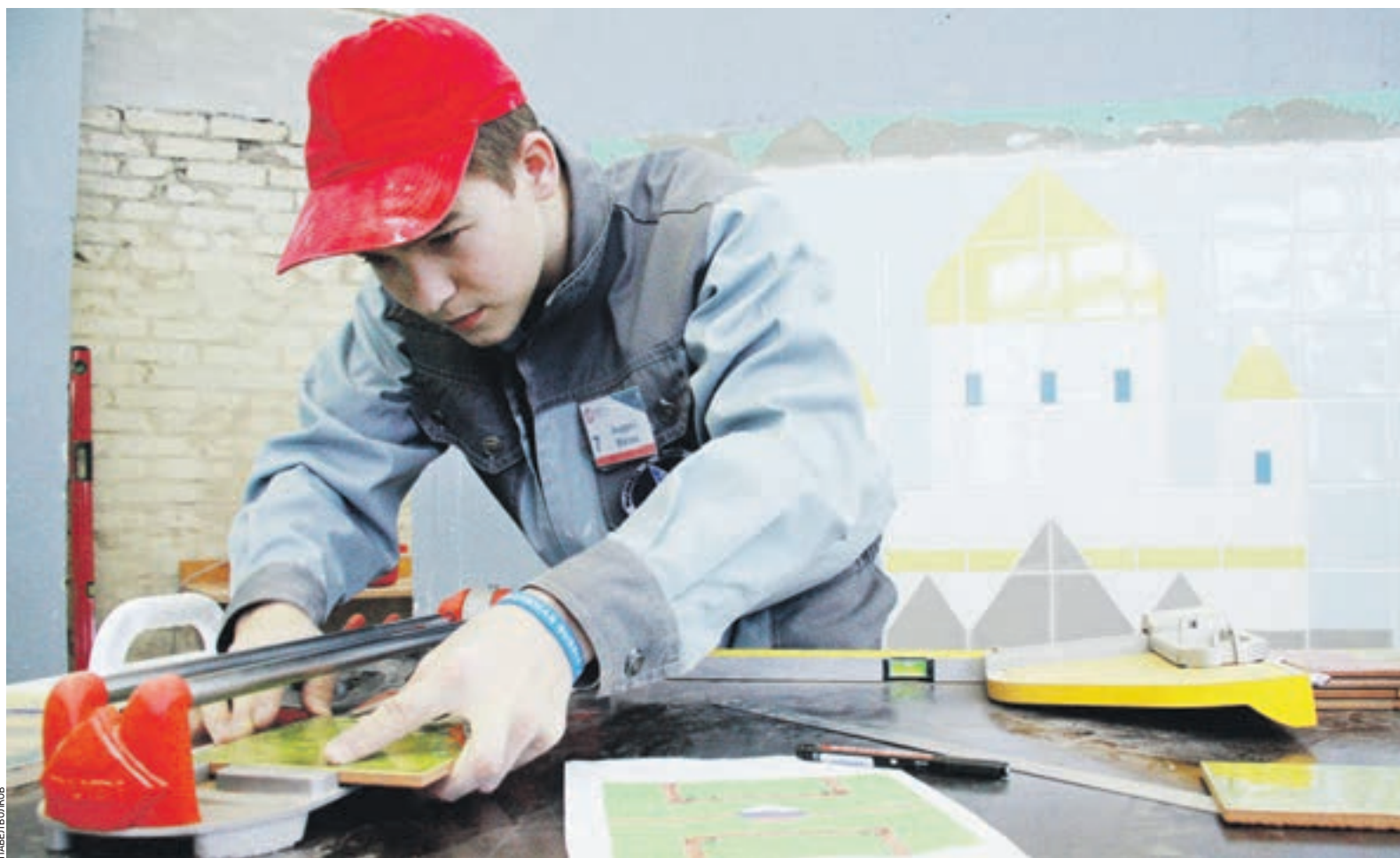
Вчера 15:25 Андрей Масюк, студент политехнического колледжа, проводит срез плитки для конкурсной облицовки
