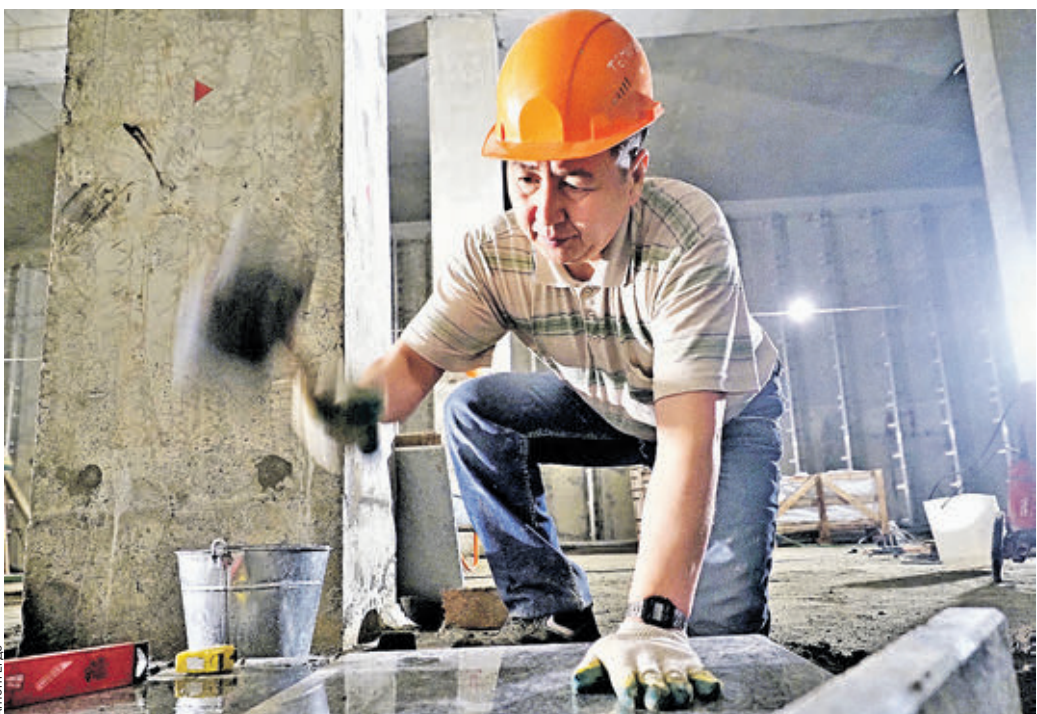
25 июля 11:42 Камнетес Каим Темирбаев укладывает гранитную плиту на строящейся станции «Авиамоторная» Большой кольцевой линии Московского метрополитена
