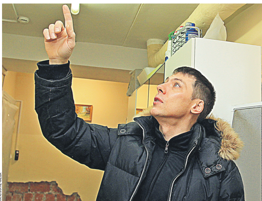
22 ноября 11:35 Житель дома № 2, корпус 1, в Большом Саввинском переулке Алексей Гудков показывает на подтеки, которые остались в подъезде после протечки крыши
