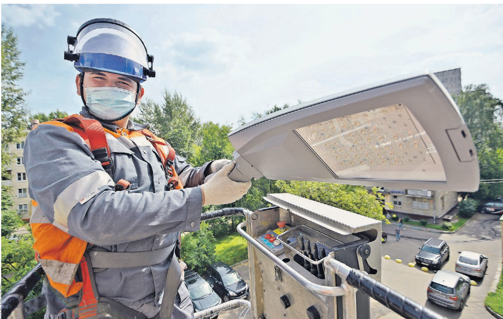
Вчера 12:34 Специалист Объединенной энергетической компании Александр Коростылев поменял устаревший светильник на светодиодный во дворе дома № 4 по улице Бажова
