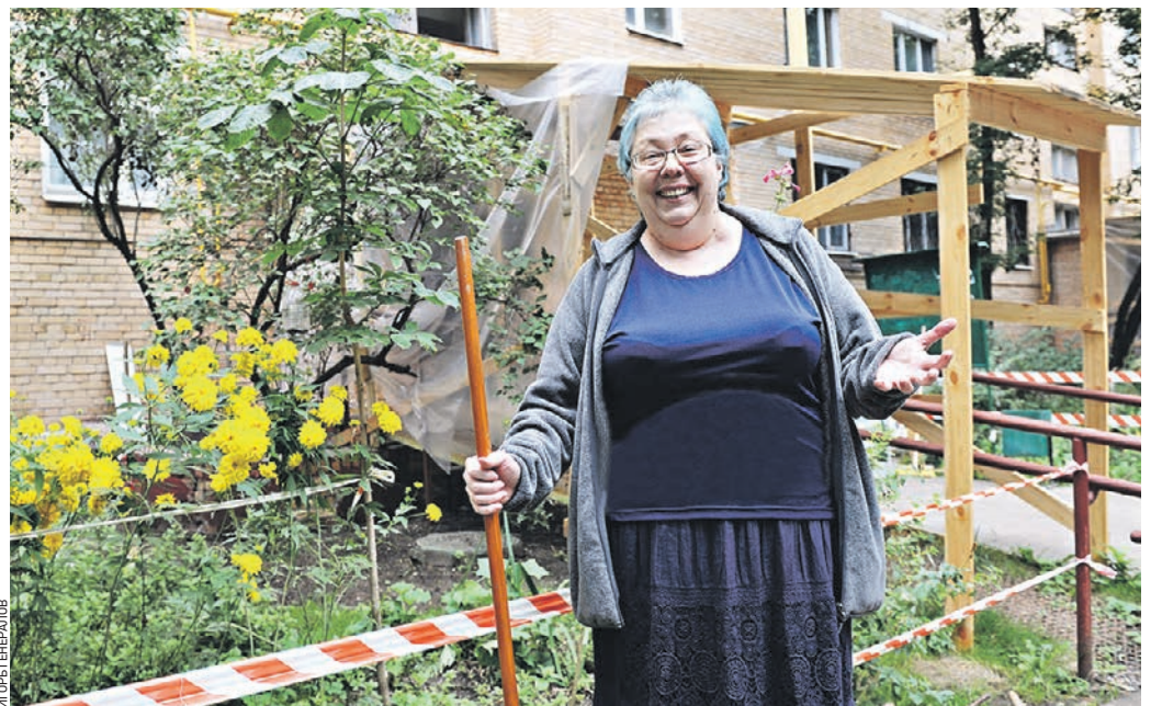
19 августа 13:10 Жительница дома №18 по улице Бориса Галушкина Лариса Киселева проведением напремонта довольна. Рабочие очень стараются, кроме того, они аккуратно обходятся с ее клумбой и даже пересаживают несколько кустов, чтобы не задеть их
