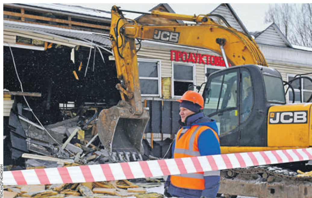
7 февраля 2020 года. Сотрудник Госинспекции по недвижимости контролирует ход демонтажа здания на территории, где может появиться зона отдыха для жителей района
