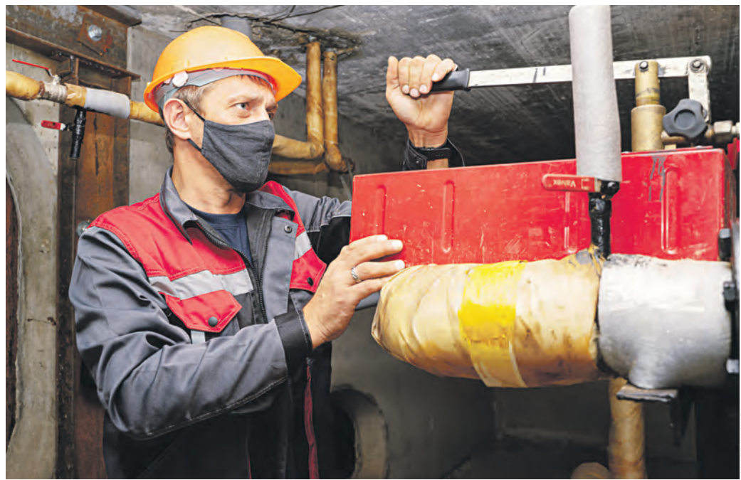
Вчера 14:39 Слесарь-сантехник ГБУ «Жилищник района Отрадное» Иван Клименко во время гидравлических испытаний системы центрального отопления
