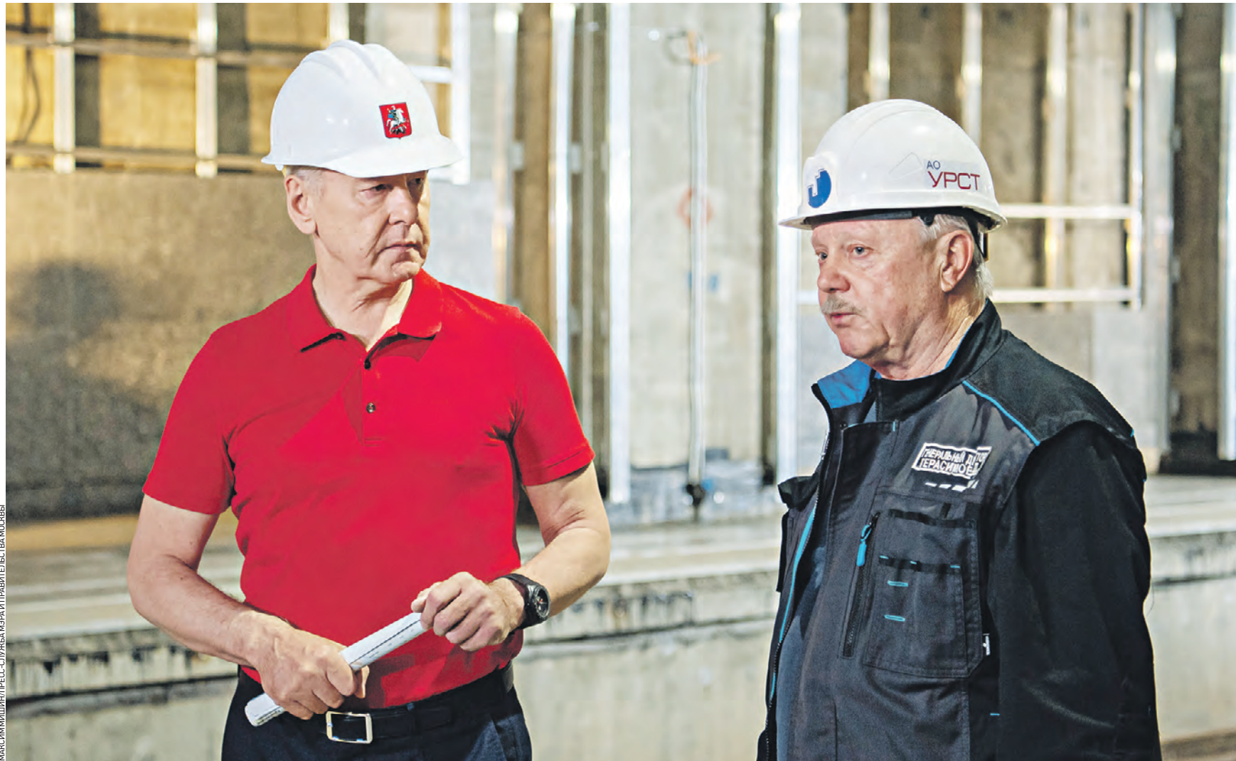
Вчера 13:17 Мэр Москвы Сергей Собянин (слева) и генеральный директор строительной компании Дмитрий Герасимов обсуждают ход работ на станции «Кунцевская» Большой кольцевой линии метро
