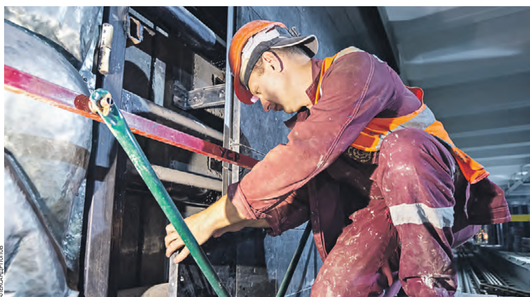
13 августа 08:18 Бригадир каменщиков Мосметростроя Сергей Толстов во время работ по отделке станции «Каховская», которая войдет в состав Большой кольцевой линии метро
