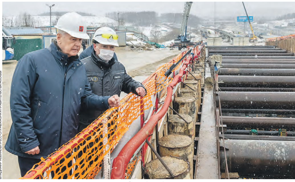
Вчера 13:47 Мэр Москвы Сергей Собянин (слева) и председатель правления строительной компании Владимир Петрук осматривали ход работ на станции «Пыхтино»
