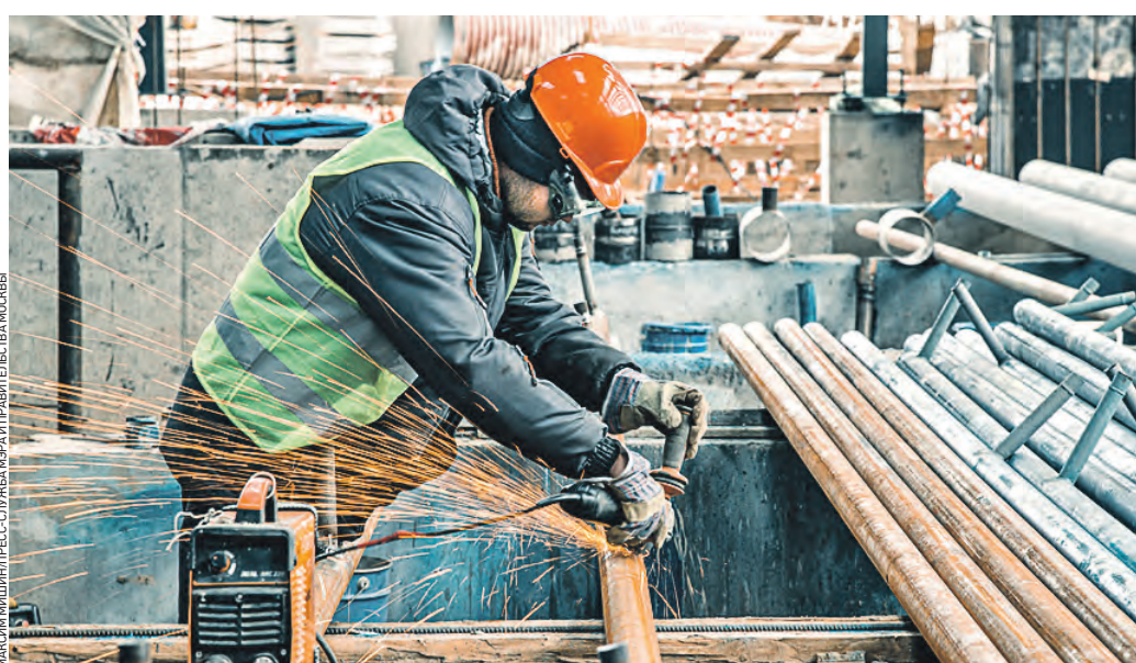
13 октября 12:26 Строитель Владимир Анисимов обрабатывает металлоконструкции в будущем электродепе «Аминьевское», которое заработает в следующем году
