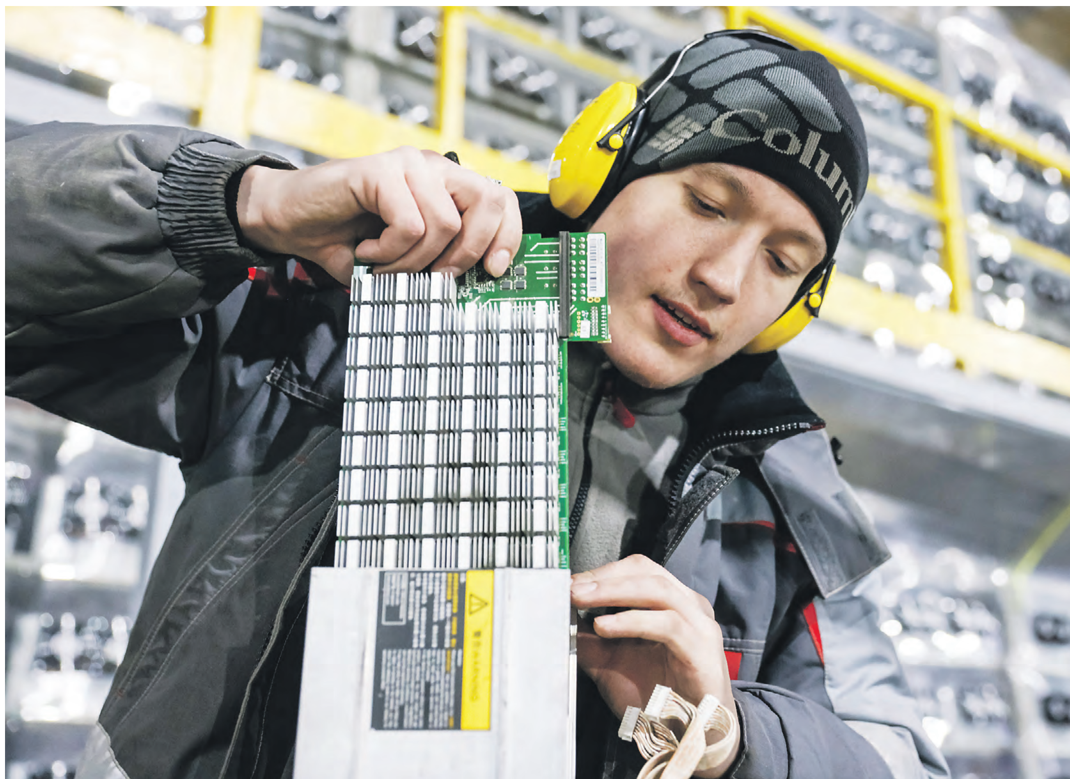
Сервисный инженер Роман Шарапов во время диагностики оборудования в машинном зале дата-центра одного из крупнейших в России провайдеров майнинга криптовалюты BitRiver. На данный момент BitRiver использует избыточную гидроэлектроэнергию для обеспечения работы крупнейшей сети дата-центров. Фото: 2022 года
