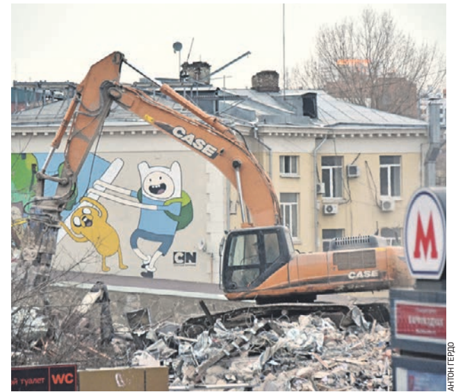
Снос незаконной постройки у вестибюля станции метро «Баррикадная». Фото 2016 года
