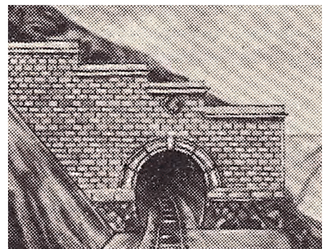
Подпорная стенка четвертого тоннеля Байкальского хребта. Срок постройки тоннеля протяженностью 800 м — 17 месяцев
