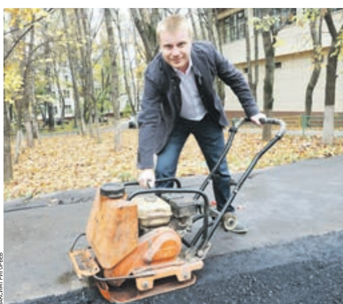
Вчера 12:10 Замглавы управы Ломоносовского района Сергей Добровольский не только проверил ход работ, но и сам утрубовал слой свежего асфальта с помощью виброплиты
