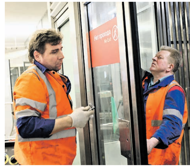
Сотрудники Московского метрополитена устанавливают вторые двери в вестибюле
