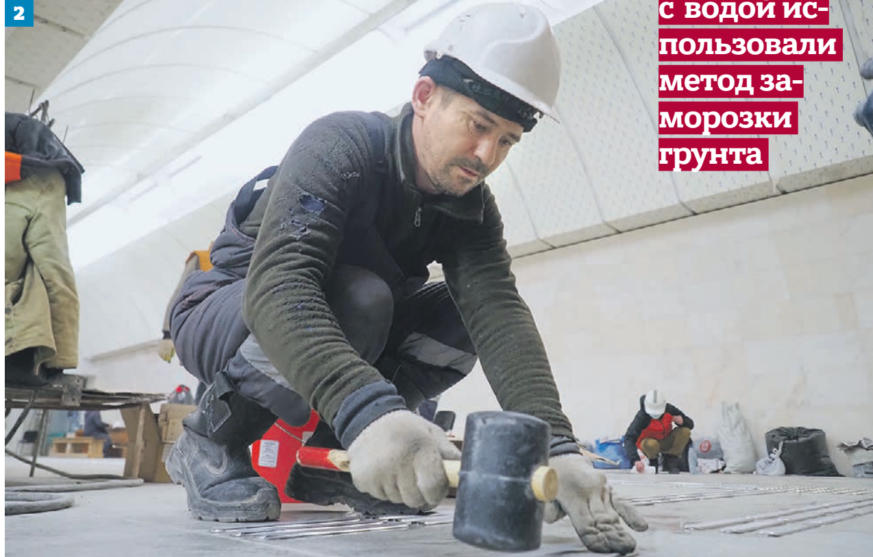
10 декабря 2020 года. Рабочий Сергей Гончаров устанавливает тактильную навигацию на полу в переходе между «Петровским парком» и «Динамо» (2) Лестница в переходе (1)
