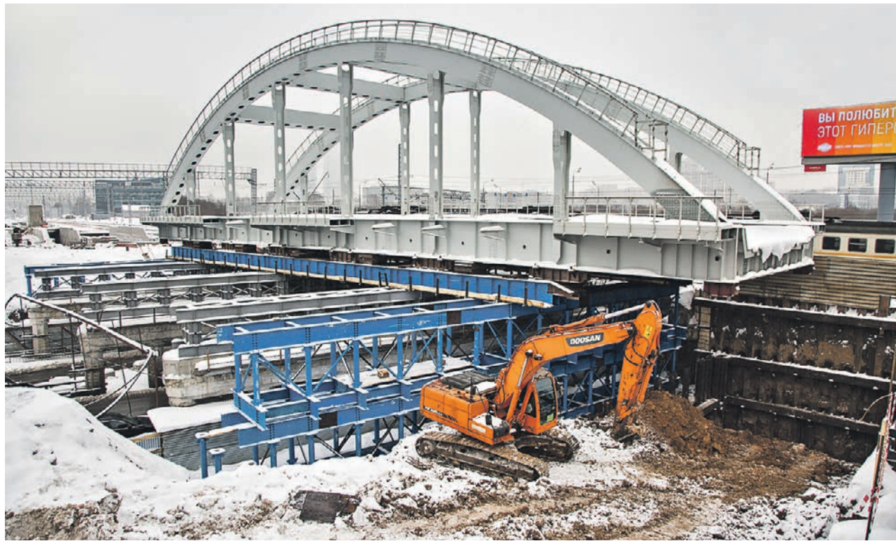
Специализированная техника работает на строительстве станции «Минская» будущего четвертого Московского центрального диаметра. Платформа откроется на Киевском направлении МЖД уже в этом году
