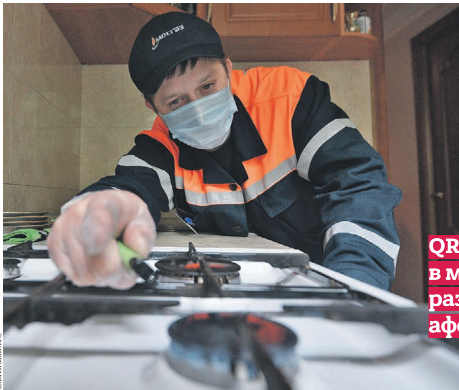
Слесарь Мосгаза Михаил Булычев проводит плановое техническое обслуживание газового оборудования
