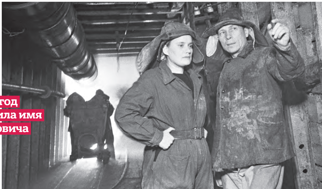
1946 год. Начальник шахты № 10 участка метрополитена «Калужская площадь» — «Серпуховская площадь» Татьяна Федорова с главным инженером Афанасием Ботовым на стройке четвертой очереди метро
