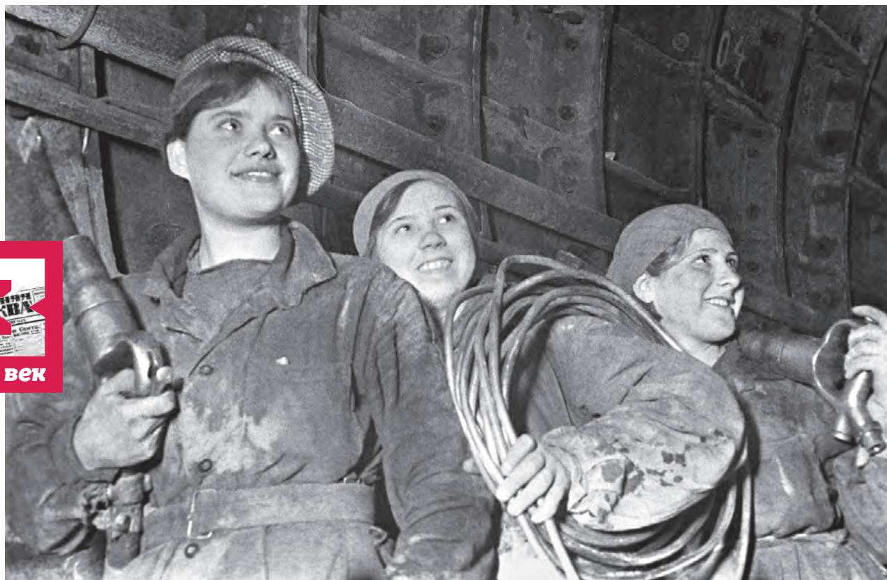
1934 год. Бригадир Татьяна Федорова (слева) и члены ее бригады на строительстве первой очереди Московского метрополитена имени Л. М. Кагановича (сейчас В. И. Ленина)
